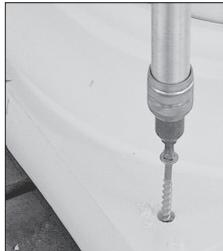
8. Aplique el pegamento a la parte inferior de la Base. Asegure con tornillos o clavos.
