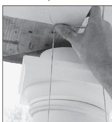
5. Apíome la columna. Asegúrese que la carga esté distribuida y centrada uniformemente alrededor de la superficie portante.
