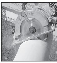
2. Use una sierra abrasiva (para manpostería o de hoja de Carburo) para emparejar la parte superior e inferior y asegurar un buen contacto con la superficie.
