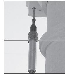
7. Aplique el pegamento a la parte superior del Capital presionando hacia arriba. Asegure con tornillos o clavos.
